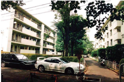
▲国際住宅(総戸数144戸/7棟)
